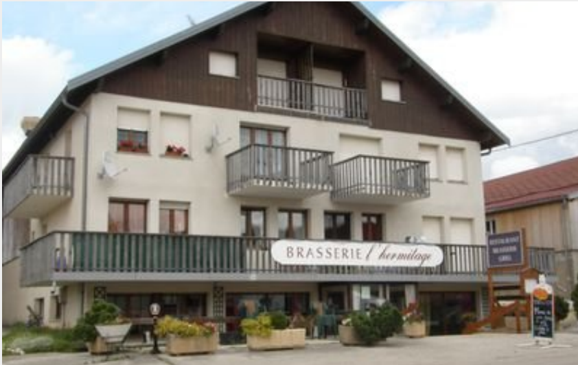
Crédit photo : RESTAURANT L'HERMITAGE_1 (otmo21)
