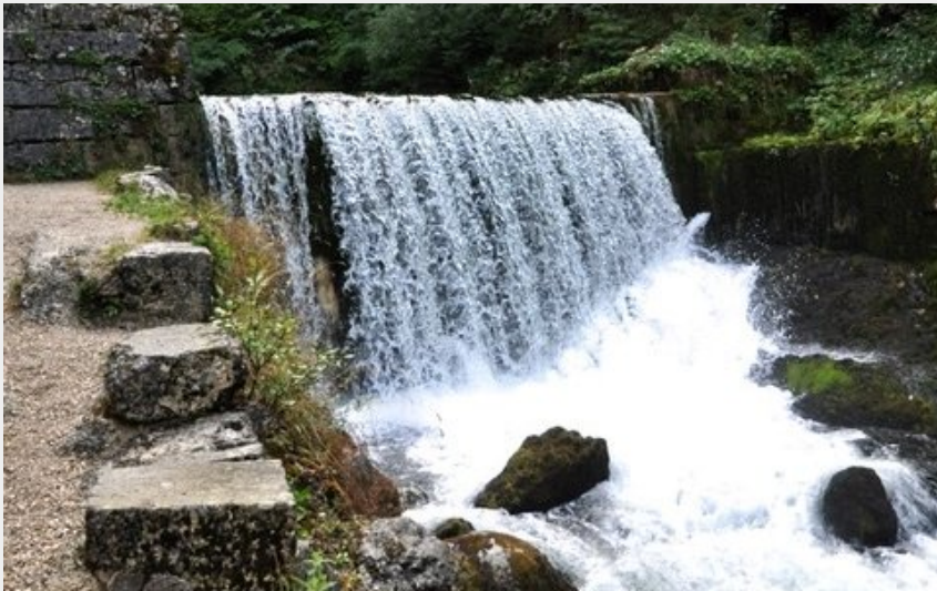
Source du Doubs (©OTPays du Haut Doubs_Philippe Deuscher)
