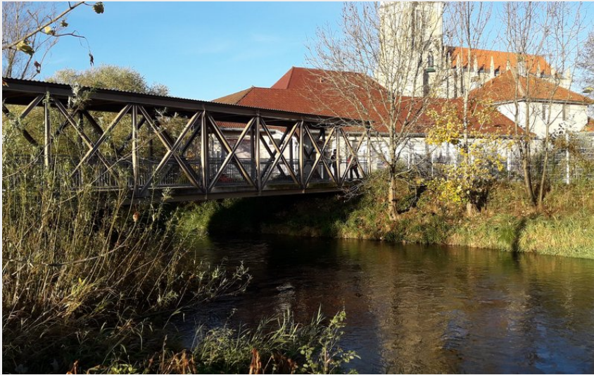
Passerelle du Moulin et Église de Doubs (CCGP)
