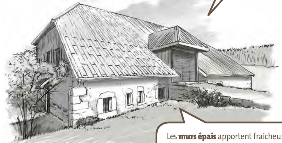
**D'étroites ouvertures verticales et horizontales** typiques des chalets d'altitude régulaient humidité et température dans la « pièce à fromager » et à la cave à fromages.
